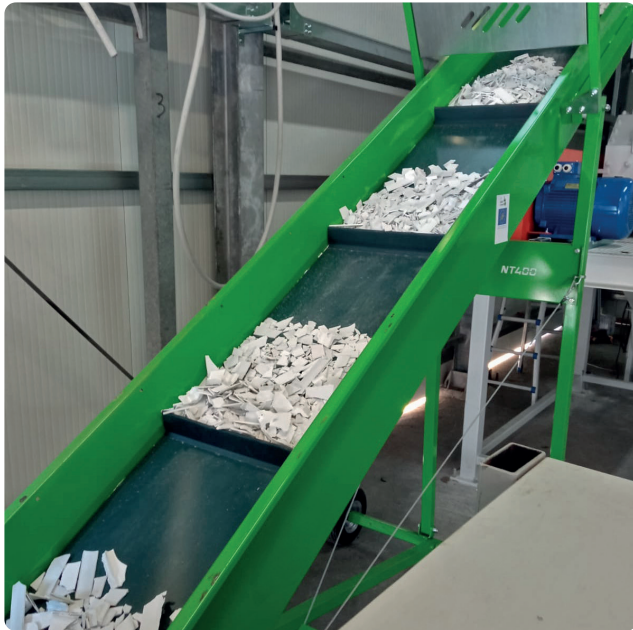
Il nastro trasportatore immette gli scarti nell'impianto di triturazione The conveyor belt feeding scraps into the grinding plant
